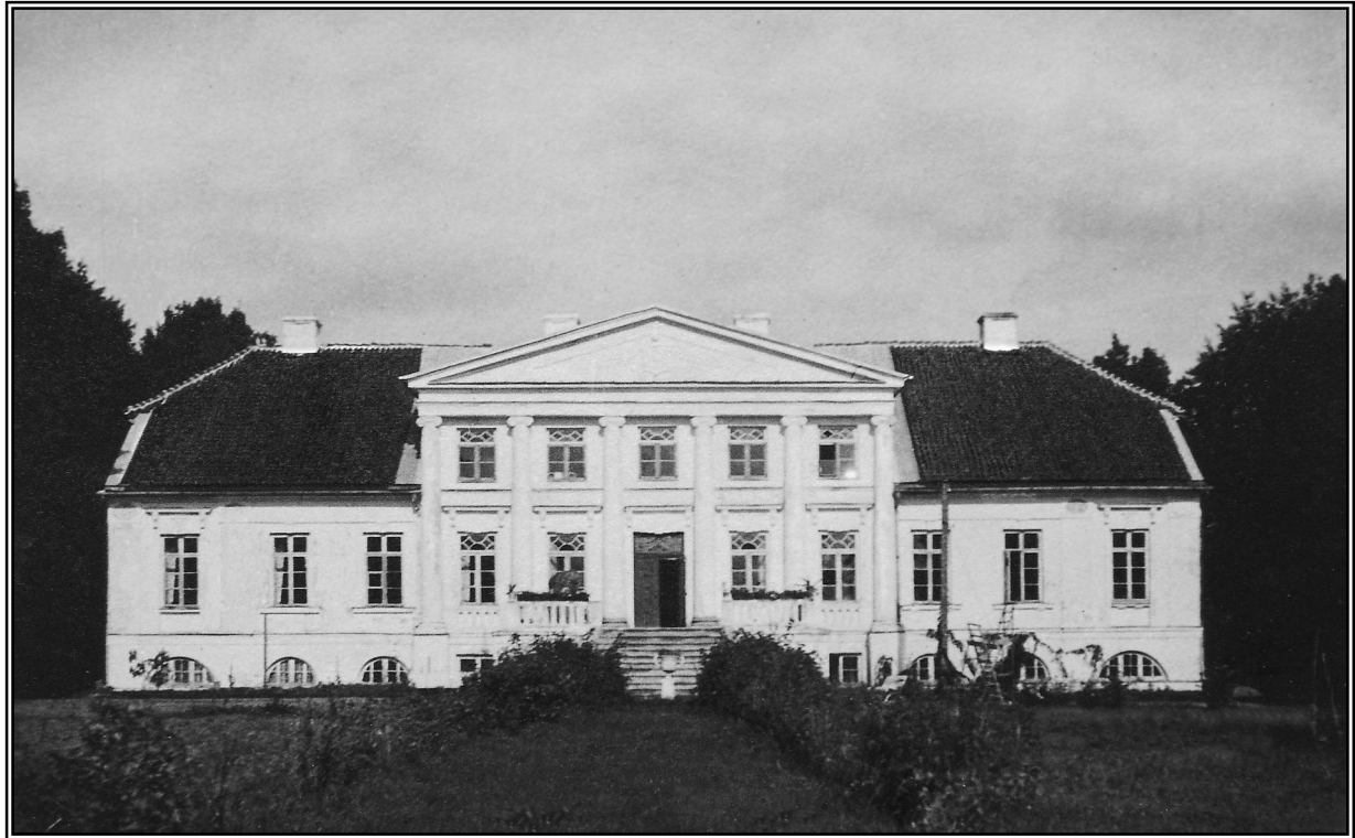
1. Nach der Renovierung um 1930
