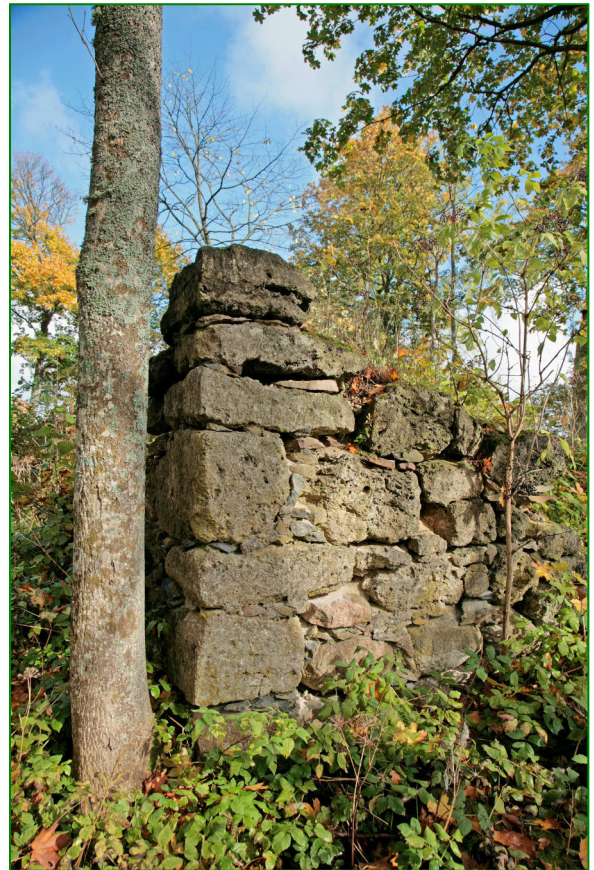
25. Tuffsteinblöcke in der süd-westlichen Ecke der Ruine von Amboten, Photo 2007
